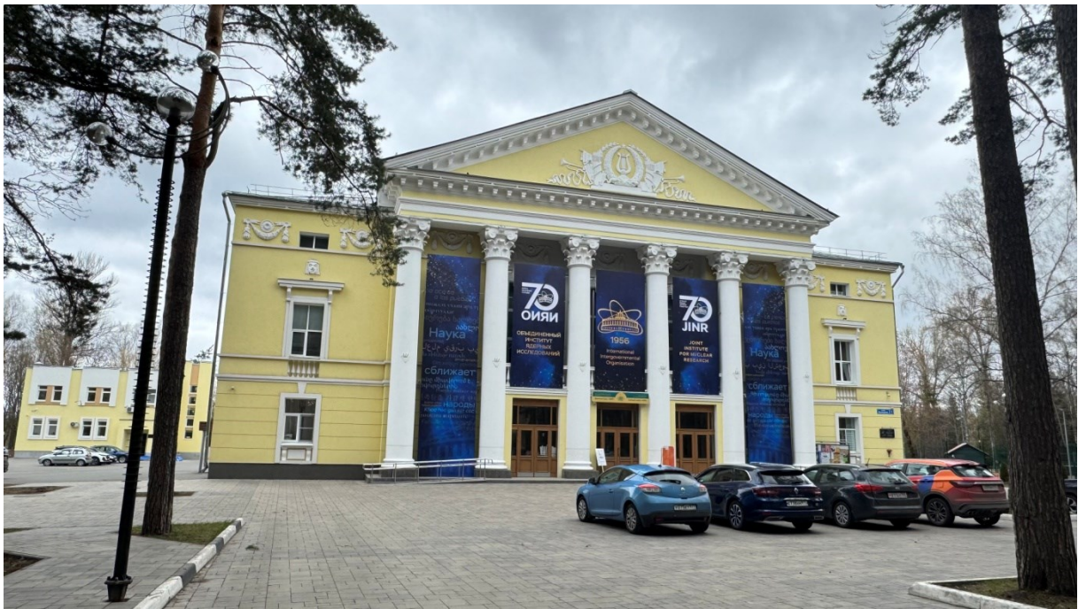
Фото переднего фасада ДК "Мир"
