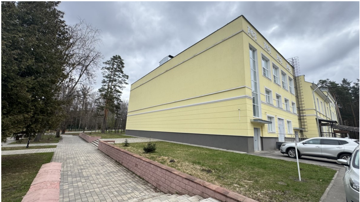
Фото заднего и бокового фасадов ДК "Мир"
